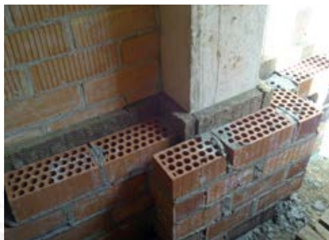
Separació acústica de tancament perimetral
