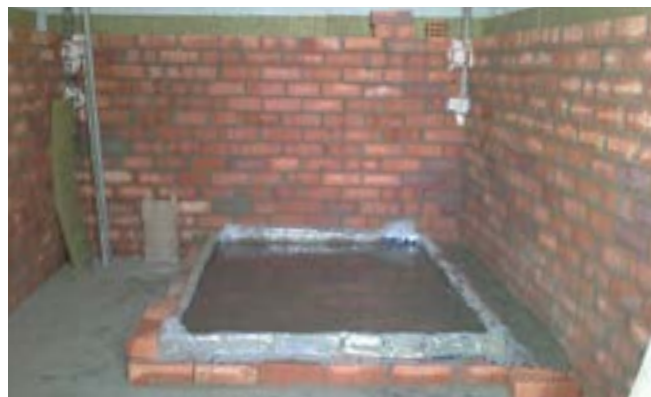
Llosa flotant antivibratòria d'obra
