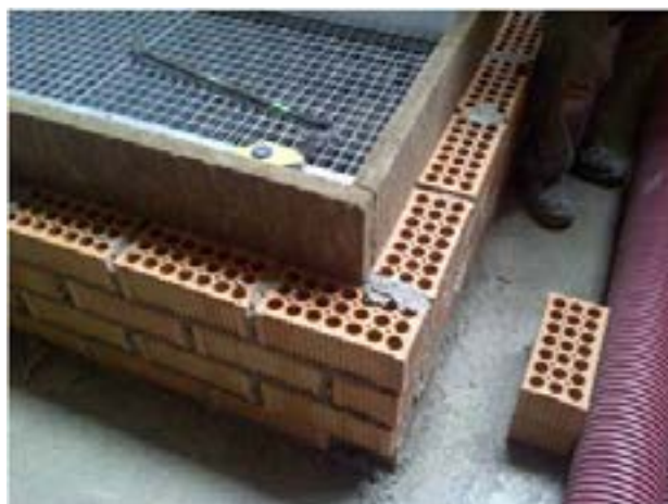
Perimetratge de llana de roca perimetral
