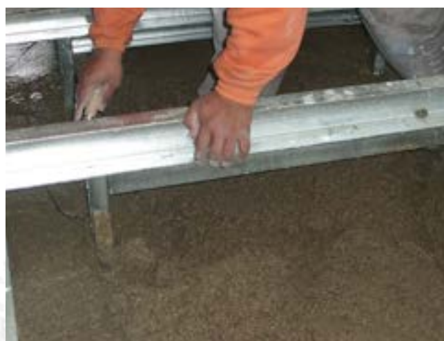
Oilbox: Formigonat interior del dipòsit antivibratori
